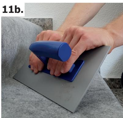
Разглаживайте флис кельмой с достаточным давлением, чтобы удалить воздушные пузыри и достичь максимальной адгезии.
