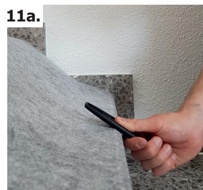
Свежее полотно заламывайте на углах лестницы тупым предметом добиваясь хорошего облегания с надёжным прилипанием.
